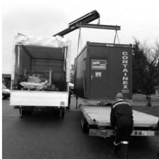
Posizionamento container bagni/docce.
