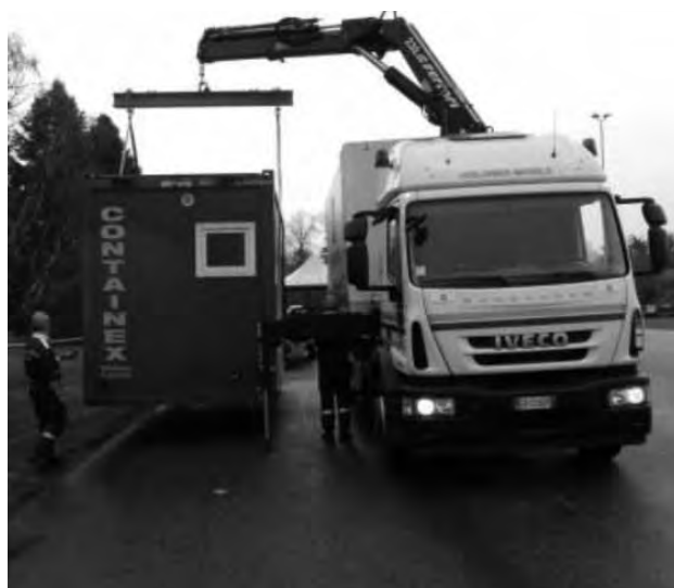
Posizionamento container bagni/docce
