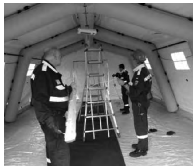
Installazione dell'impianto di illuminazione
