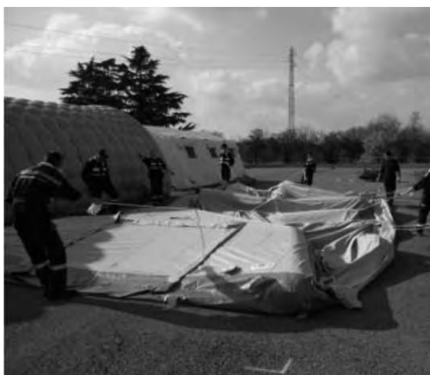
Fase del montaggio di una tenda pneumatica.
