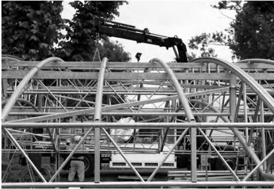
Fase di montaggio della tensostruttura mensa che ha richiesto una squadra di 16 persone
