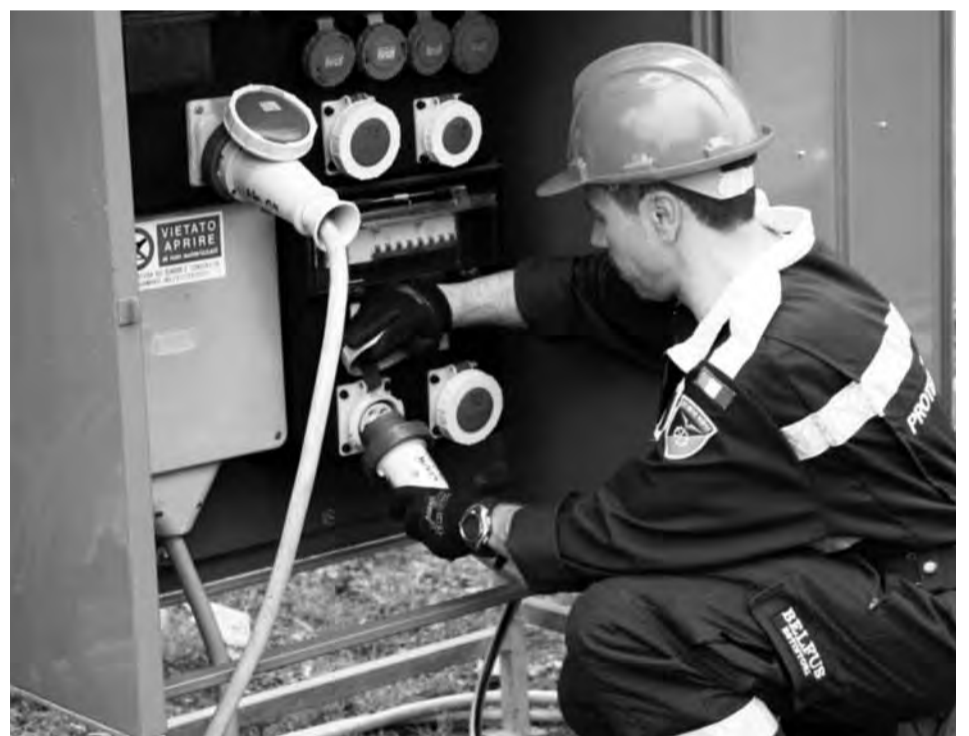
Installazione del quadro elettrico generale di distribuzione a tutto il campo
