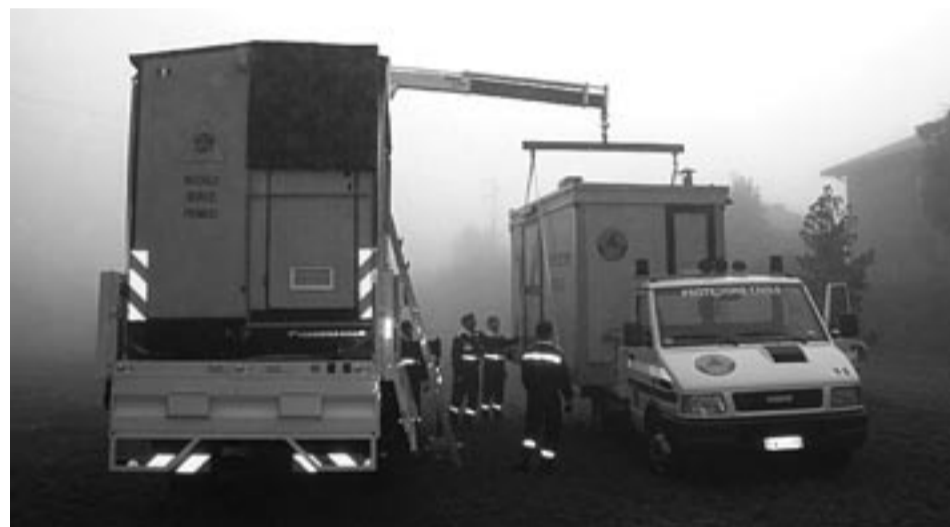
Scarico dei moduli servizi igienici e cucina
